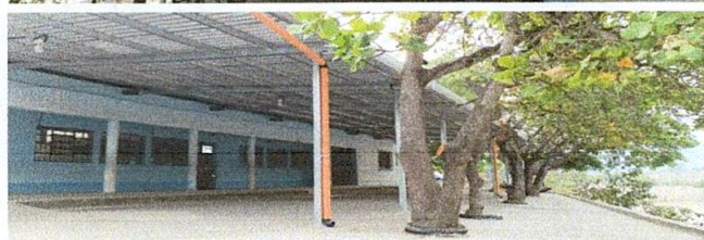
Foto 3: Otro ángulo del área donde se construyó la estructura metálica y techo de lámina, espacio que será utilizado para poder realizar reuniones con padres de familia y realizar diferentes actividades educativas.
