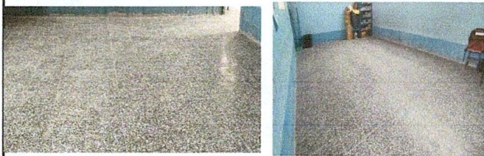
Foto1: Se instaló Piso granito nuevo en aulas para que tengan un ambiente agradable para los niños y que fortalezca el proceso de enseñanza aprendizaje con piso nuevo.
